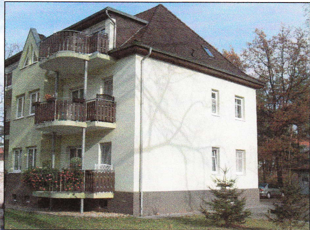
Ansicht Südgiebel (SW-Ecke)
