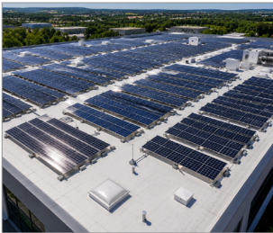
auf Flachdächern mit hoher thermischer Belastung
